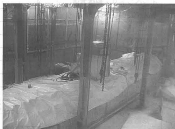
分析セル解体中 (遮へい体及びインナーボックス撤去)
